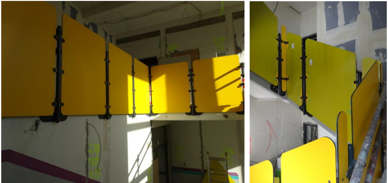
Neue Gestaltung der Treppengeländer
