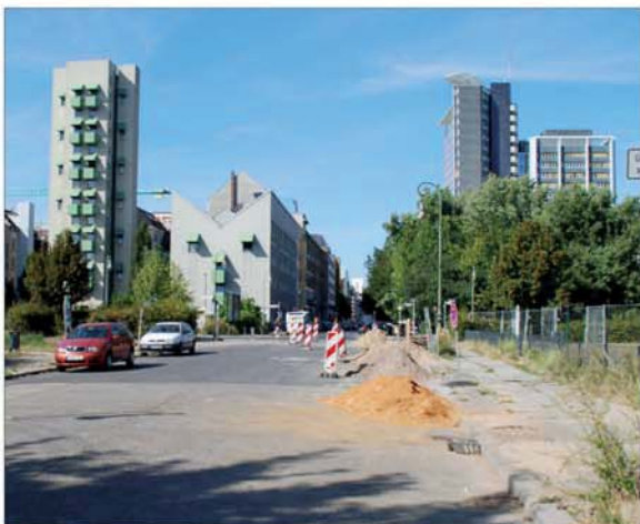
Enckestraße: der Straßenraum bietet einen dringend erneuerungsbedürftigen Zustand.
