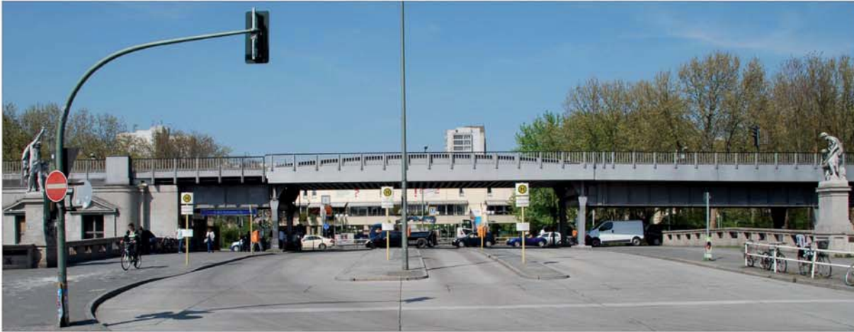
Die Fläche auf der Hallesches-Tor-Brücke ist rein funktional gestaltet und zum Aufenthalt für Fußgänger unattraktiv, die städtebauliche Bedeutung ist nicht erlebbar.
