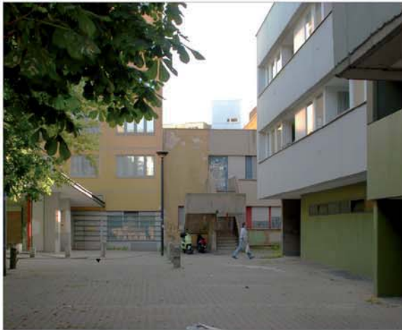
Der Außenraum und die Fassaden sind vielfach noch im Bauzustand der Gebäude um die Mitte der 70er Jahre.
