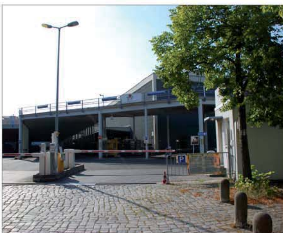
Der Blumengroßmarkt soll zur Dependence des JMB werden. Hierzu sind umfangreiche bauliche Maßnahmen erforderlich.
