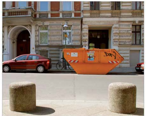
Die gründerzeitliche Wohnbebauung an der Gneisenaustraße unterliegt seit vielen Jahren einem Modernisierungsprozess.
