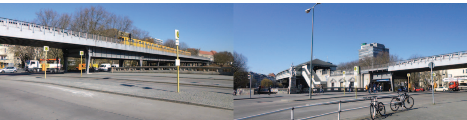
Hallesche-Tor-Brücke | Aufnahmen: asum GmbH
