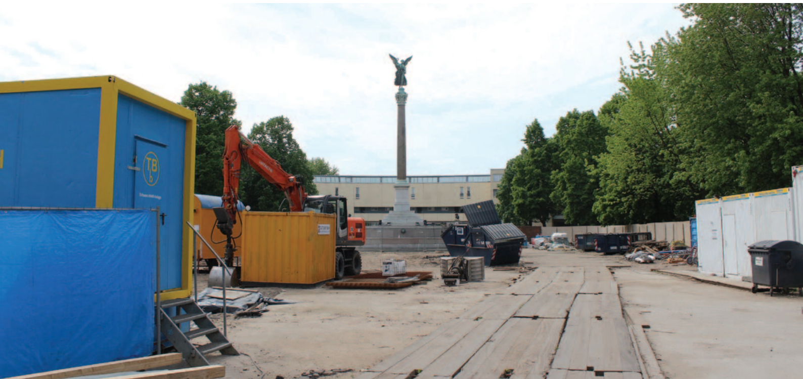
Mehringplatz mit Baustellensituation | Aufnahme: asum GmbH
