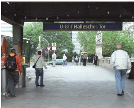
36 unattraktiver Durchgang Hallesche-Tor-Brücke
