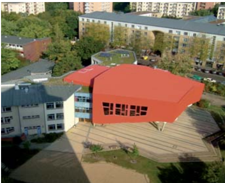
68 Neubau Waldorfschule, Ritterstraße
