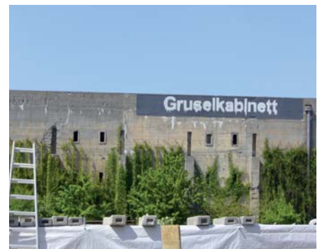
75 Hochbunker Schöneberger Straße
