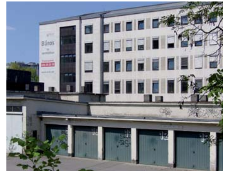
74 Eisenbahnbundesamt Hallesches Ufer, Rückseite
