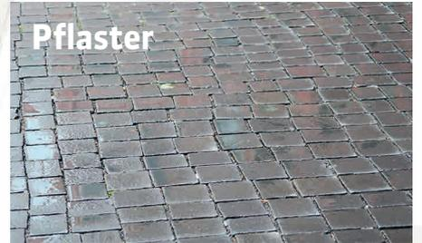
Im Ring wird Kleinpflaster und Mosaikpflaster aus Granit und Basalt verlegt. Gewählt wurde ein glatter Belag, der auch für Gehbehinderte komfortabel ist und nebenbei auch die Geräusche von Rollkoffern mindern soll. Im äußeren Ring wird es einen zwei Meter breiten asphaltierten Streifen geben. Das Pflaster unter dem Luftgeschoss der inneren Ringbebauung bleibt erhalten und wird, falls nötig, ausgetauscht. ■
